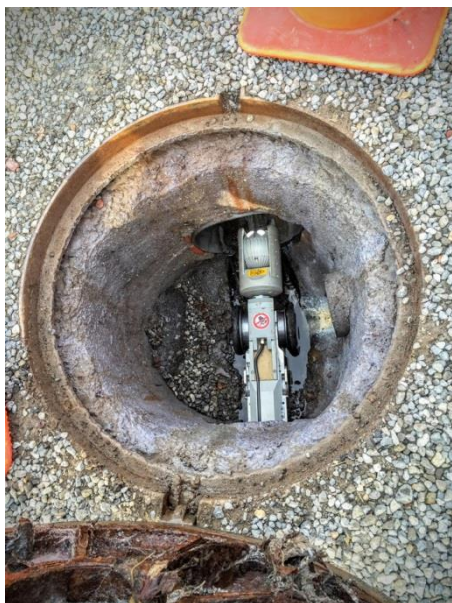
Photo 9 Caméra-canalisation (source: CRR)
